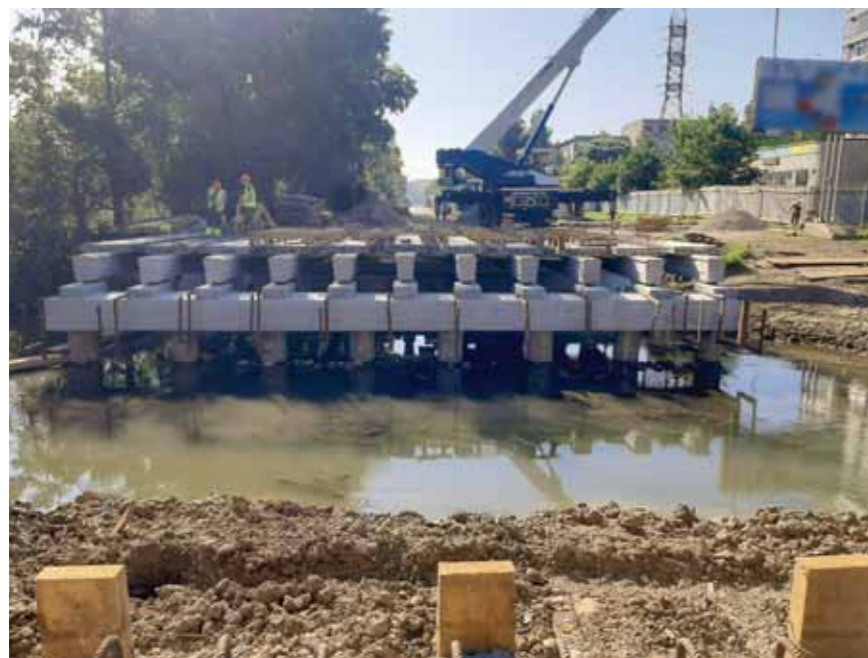
Капитальный ремонт моста через реку Содему на улице Петина
