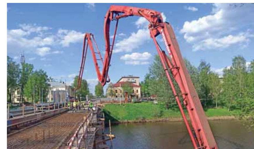
Капитальный ремонт моста в створе улицы Луначарского в Вытегре
