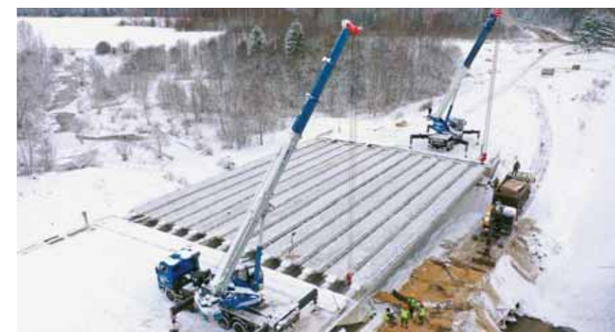
Продолжается капитальный ремонт моста через реку Кисьму в Ярославской области
