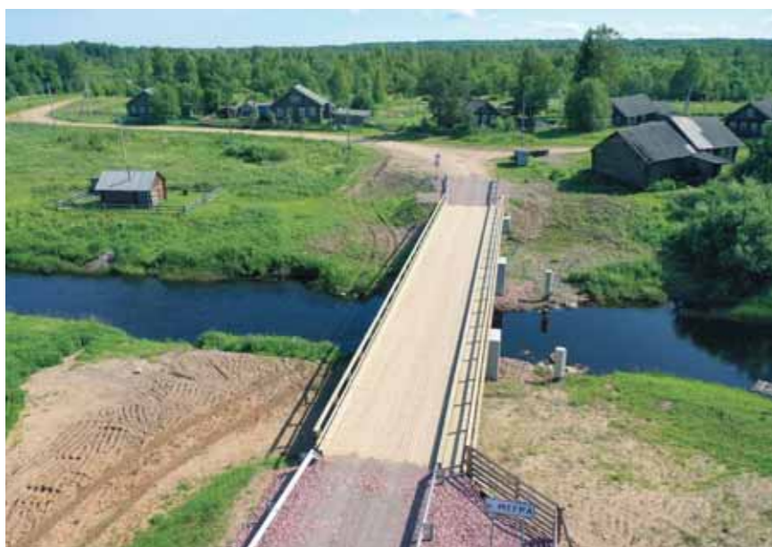
Завершен ремонт деревянного моста через реку Мегру в селе Коштуги
